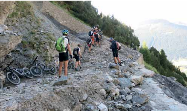
Abgerutschte Strasse auf dem Weg zum Passo da Val Viola
